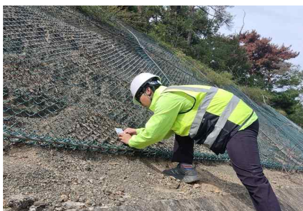
절리면 경사/경사방향 측정
